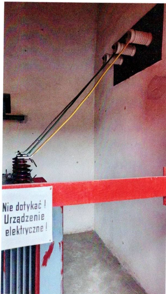
2. Zdjęcie szyn 15kV zasilających transformator Nr-1 15/0,4kV, oraz izolatorów przepustowych do demontażu
